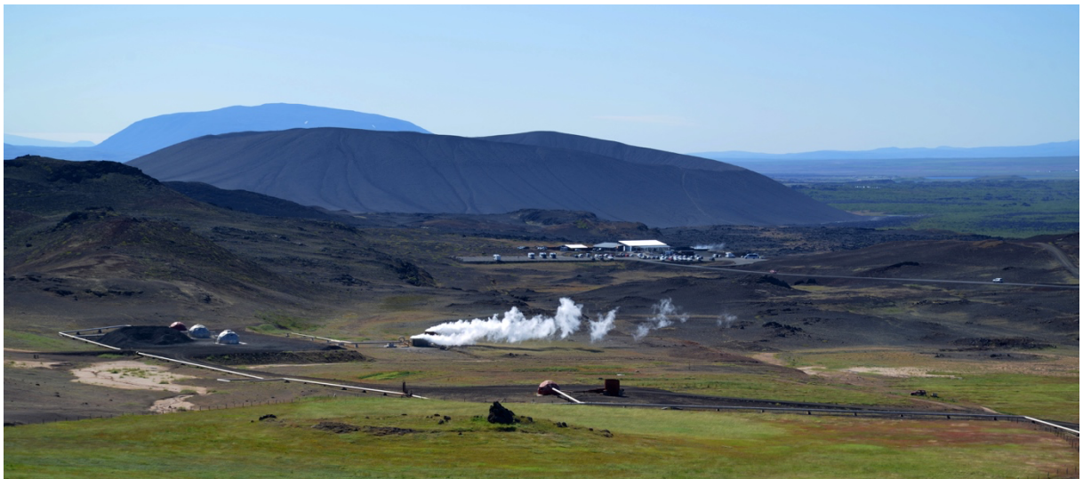
Geothermisches Kraftwerk in Island
